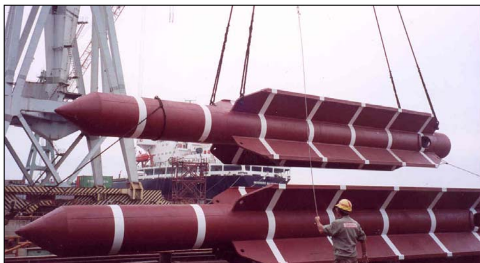
Figura II.2.4-6 - Estaca do tipo torpedo a ser utilizada na ancoragem do FPSO Cidade de Niterói.
